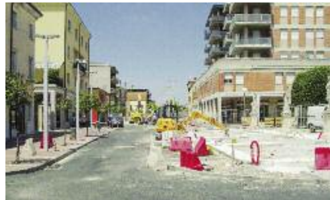
UN CENTRO IN FASE DI RIQUALIFICAZIONE - Il lavoro su via Paride sta riguardando non solo il rifacimento del manto stradale ma anche la promozione di tutto il sistema economico che ruota attorno al centro cittadino
