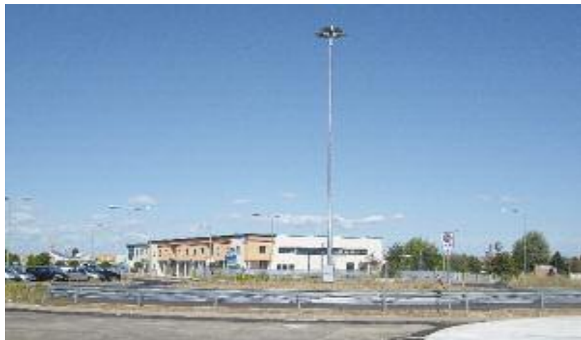
RIQUALIFICATA UN'INTERA AREA - I lavori hanno permesso il recupero di una piazzola polivalente e la realizzazione di un nuovo tratto di pista ciclabile.
