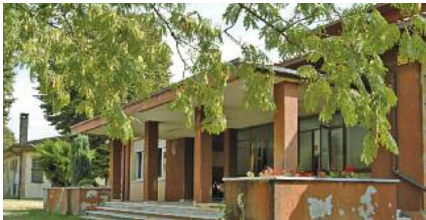
SOPRA E SOTTO SCUOLA ELEMENTARE DI ASPARETTO E PLESSO SCOLASTICO VILLAGGIO TRIESTE - I due interventi sono stati realizzati durante l'estate. Nel primo caso sono stati messi in sicurezza i solai, mentre nel secondo edificio è stata sistemata la copertura e sono state sostituite le plafoniere
