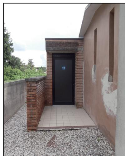
I servizi igienici per il pubblico sono localizzati all'esterno della recinzione. Si distribuiscono in un antibagno e due wc, che per caratteristiche geometriche e dotazioni, non risultano accessibili ed utilizzabili da persone con disabilità motoria. In ogni caso l'accessibilità a persone su carrozzina è ulteriormente inibita a causa del percorso in ghiaio e del salto di quota da quest'ultimo verso la parte pavimentata.
