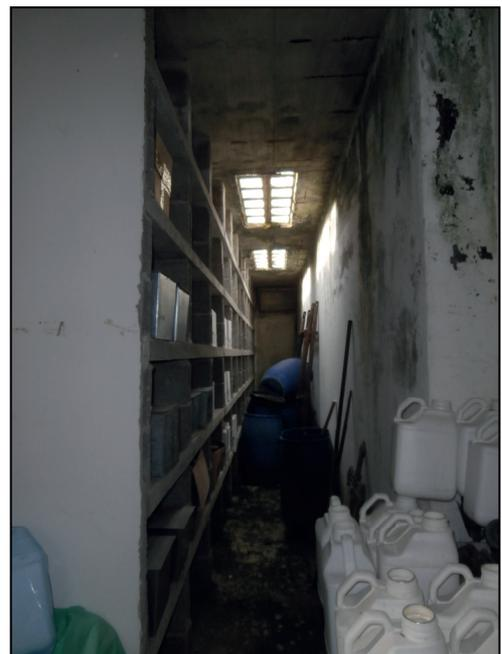
Lo spazio si articola in relazione ai soprastanti percorsi tra le tombe di famiglia, in una conformazione scarsamente idonea per spazi di sepoltura. L'attuale stato di conservazione è cattivo con un generale degrado che riguarda essenzialmente infiltrazioni d'acqua dalla copertura ed il distacco di tessere dal rivestimento. Solo il primo corridoio presenta ancora l'aspetto previsto dal progetto, anche se gran parte delle sepolture sono state traslate.
