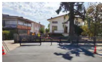
Sono stati eseguiti alcuni lavori di manutenzione straordinaria di strade, piazze e percorsi. **Nello specifico si è realizzato un nuovo dosso e attraversamento pedonale, altamente visibili e rialzati, con nuova illuminazione in via Marconi.** Intervento che permetterà la riduzione della velocità e l'attraversamento in sicurezza. È intenzione dell'Am-
