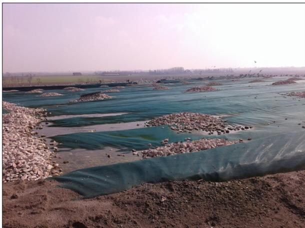
Figura 5: copertura provvisoria con teli (13/03/2014)
