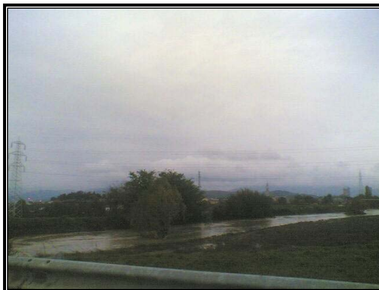
Figura 12: Torrente Alpone ponte SR 11 – 1 novembre 2010
