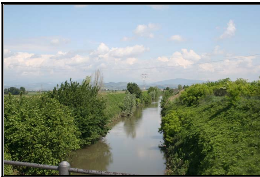
Figura 8: Torrente Alpone –foto verso Nord dal ponte di Arcole
