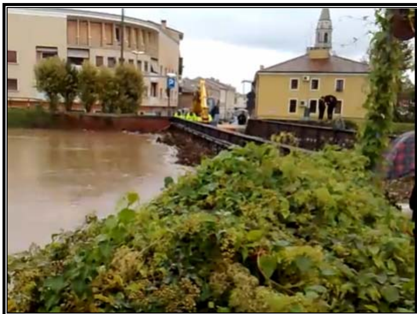
Figura 11: Ponte della Motta – 01 novembre 2010
