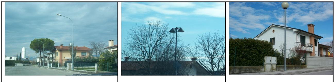
Considerando la combinazione tra diversi tipi di sostegni e modelli di apparecchi, vi sono circa una cinquantina di tipologie diverse, tra cui la più numerosa con quasi trecento punti luce è la configurazione con l'armatura detta Orsa maggiore e il palo con sbraccio curvato alto 9 m.
