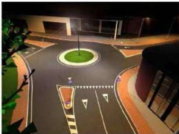
Figura 64 – Esempio rotonda compatta
