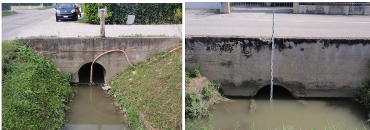
Foto 3: tombinamenti sottodimensionati sullo scolo Pionchetta Nord (sinistra) e Bolengà (destra)
