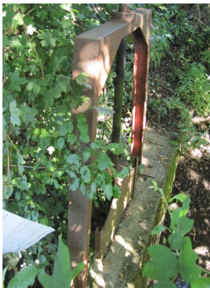
Foto 10: paratoia sul fosso di guardia della ferrovia ed immissioni in Pionca nella zona arginata. Prevista installazione di porte a vento
