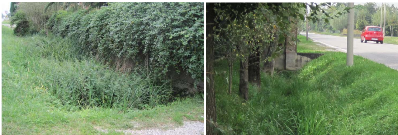
Foto 8: esempi di capofossi parzialmente ostruiti, da pulire e ricalibrare e di tombinamenti da spurgare
