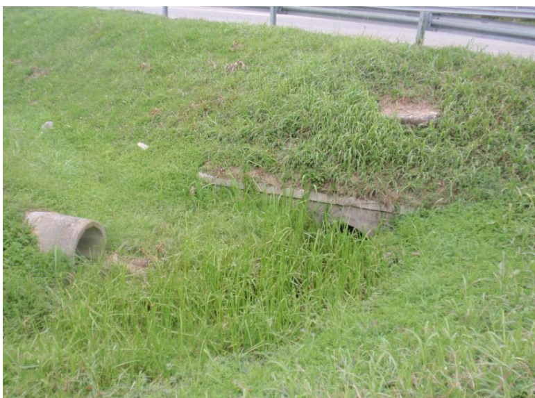
Foto 6: tubazione di attraversamento della SP con sbocco parzialmente ostruito da spurgare
