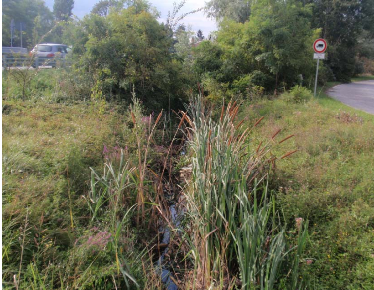
Foto 7: fosso principale tra la SP e Via Pionca in cattivo stato di manutenzione, da pulire e risezionare
