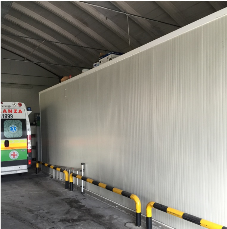
Vista interna Uffici prefabbricati AVP
