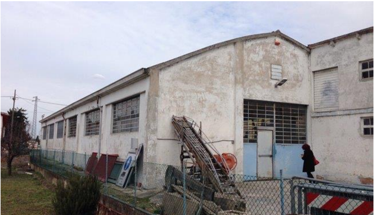
Fronte su Via Matteotti Ingresso Magazzino Comunale.
