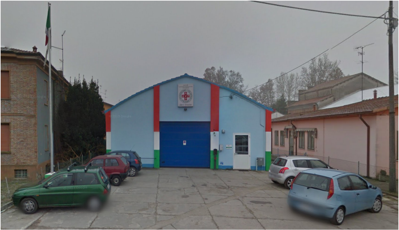
Fronte su Via San Martino Ingresso sede A.V.P.
