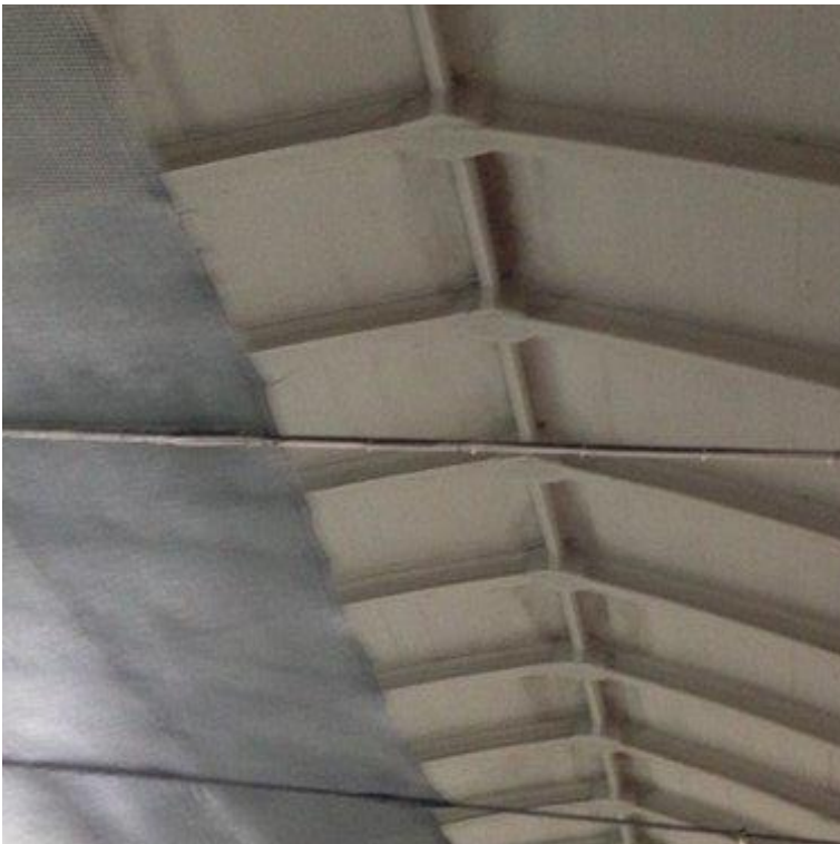
Vista interna copertura
