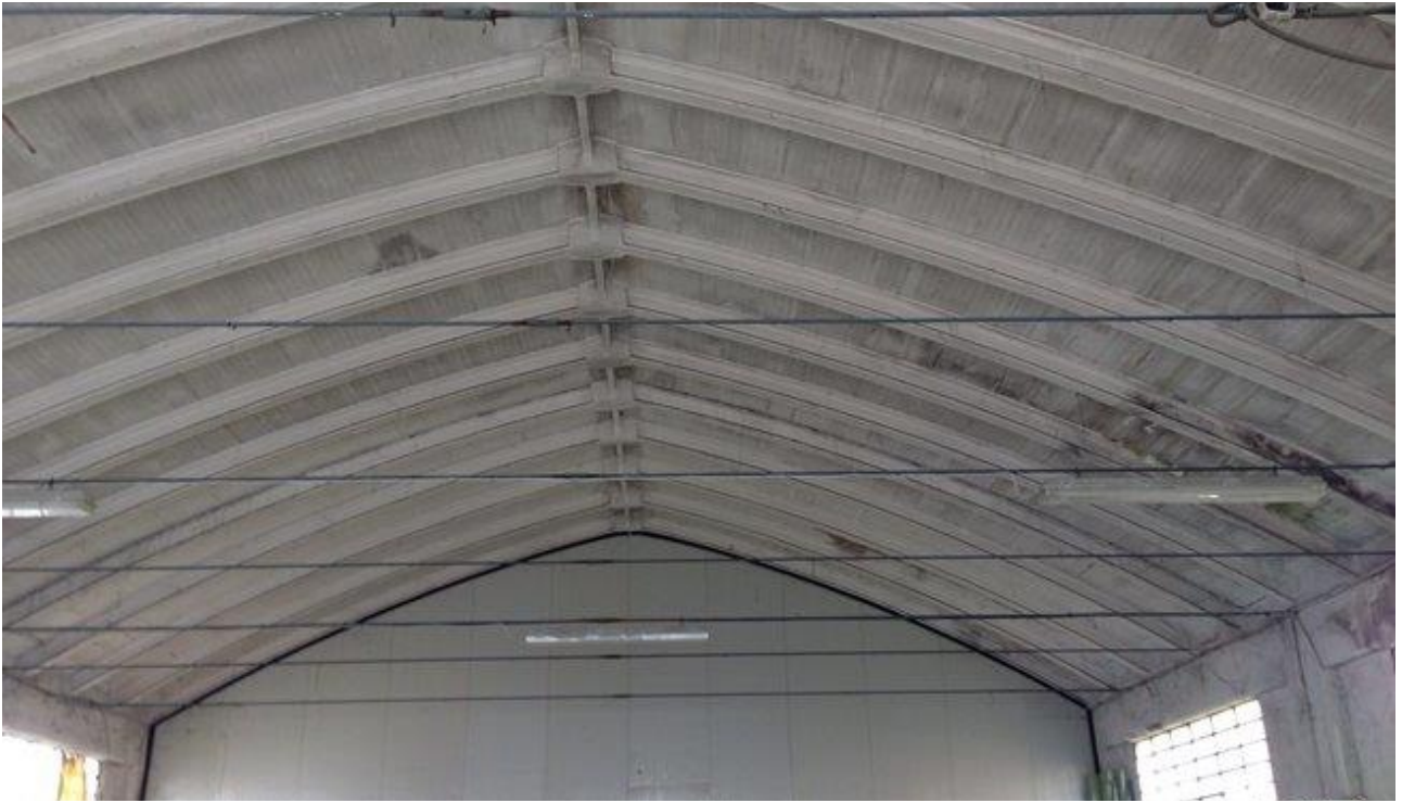
Vista interna copertura
