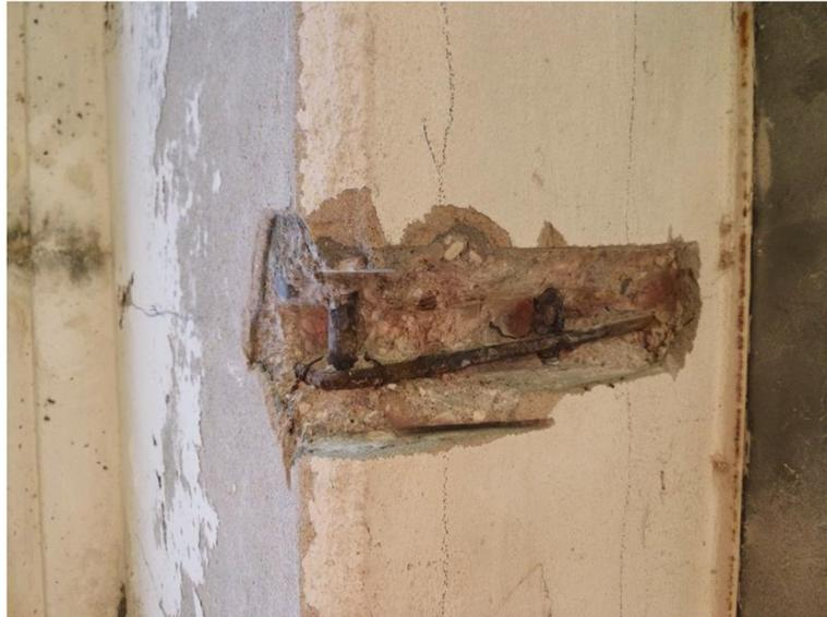
Figura 5: localizzazione e determinazione del tipo e del diametro delle barre longitudinali e trasversali – indagine ID 06
