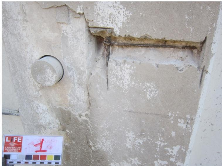
Figura 6: localizzazione e determinazione del tipo e del diametro delle barre longitudinali e trasversali – indagine ID 01
