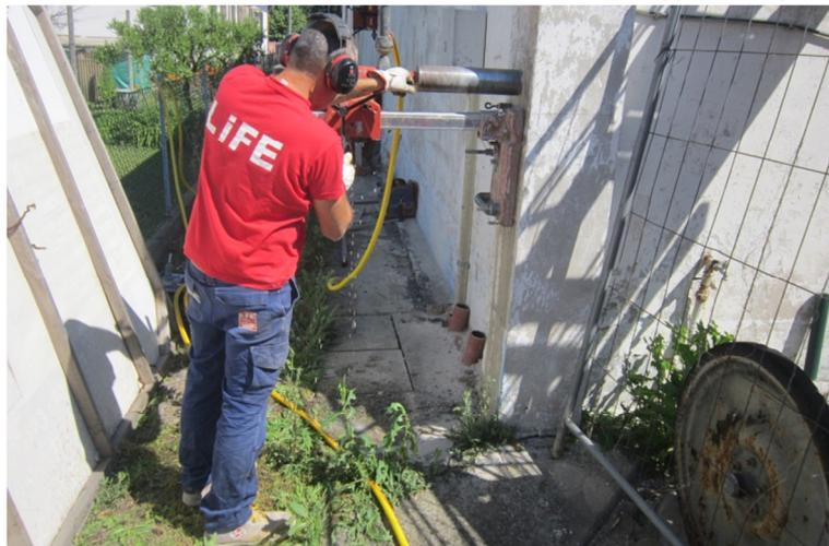
Figura 9: prelievo di campione mediante carotaggio – indagine ID 05
