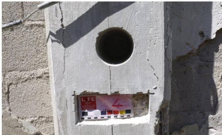
Figura 8: area in cui è stato prelevato il campione mediante carotaggio – indagine ID 04
