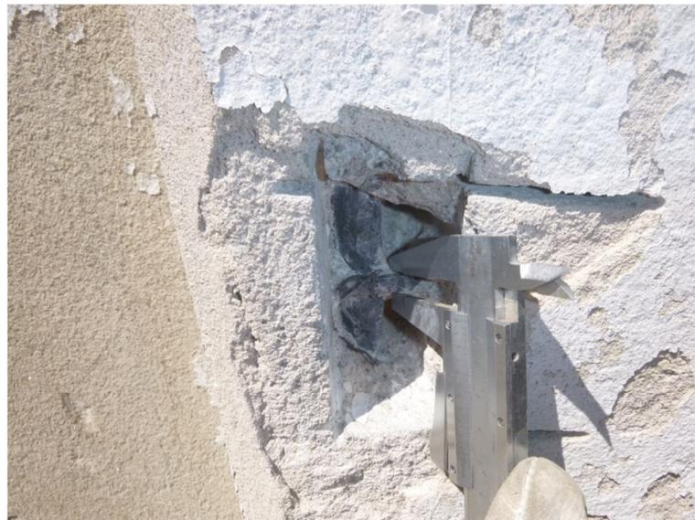
Figura 3: misura diretta del diametro delle armature longitudinali - indagine ID 02
