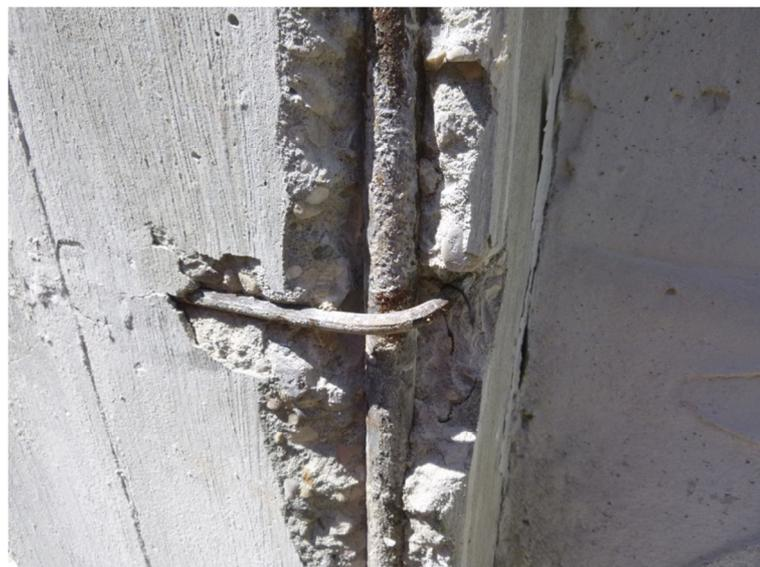
Figura 4: localizzazione e determinazione del tipo e del diametro delle barre longitudinali e trasversali – indagine ID 04
